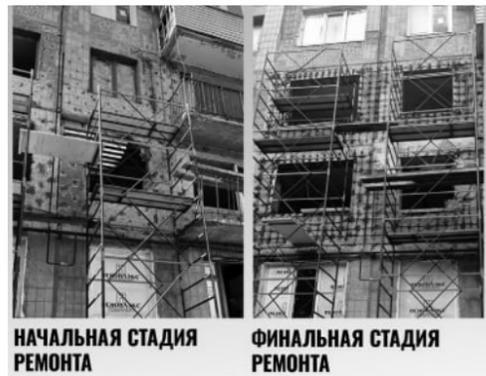
В результате прямого попадания снаряда ВСУ были повреждены внешние несущие стены трёх квартир и пробиты плиты перекрытия сразу на трёх этажах.
