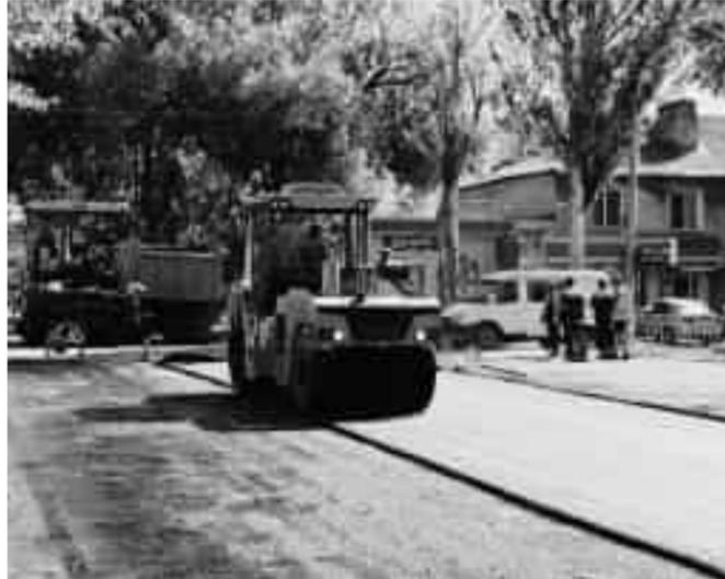
Ведутся работы по укладке асфальтобетонного покрытия на подготовленный участок проезжей части дороги по ул. Рудакова. Проводится подготовка, выравнивание дорожного профиля по ул. Академика Павлова.
