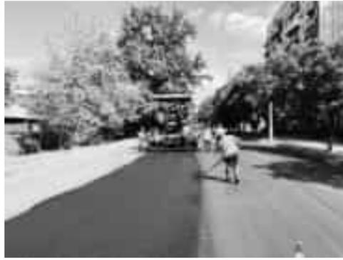
В Горловке ведется укладка асфальтобетонного покрытия на подготовленный участок проезжей части дороги по улице Гагарина.
