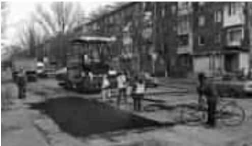
Дорожники МУП «ПРОСТОР» АГГ приступили к укладке асфальтобетонного покрытия на подготовленный участок проезжей части дороги по ул. Гагарина.
