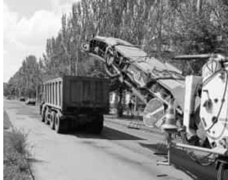
По проспекту Ленина в Горловке дорожники продолжают работы по фрезерованию. На сегодня отфрезеровано порядка 23 тыс. кв. м дорожного покрытия при плане 94 тыс. кв. м.
